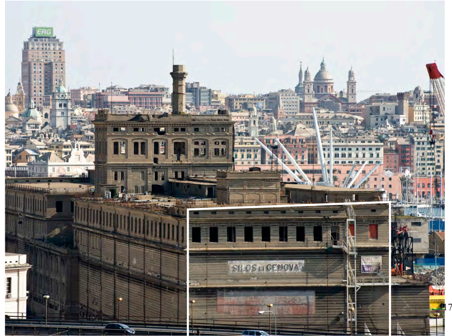
FACCIATA OVEST DA CONSERVARE
