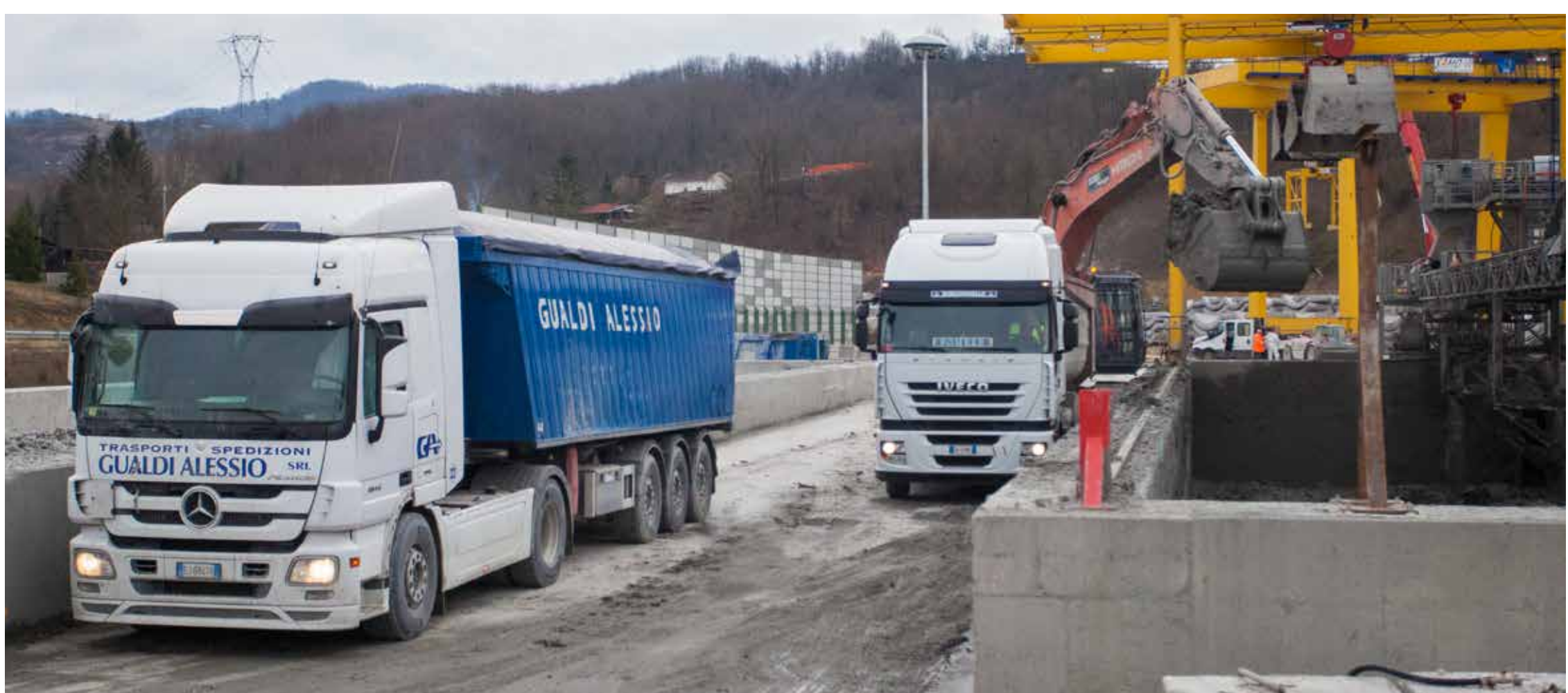
AUTOCARRI CON CASSONI A TENUTA PER IL TRASPORTO DI TERRE CLASSIFICATE COME SOTTOPRODOTTO
