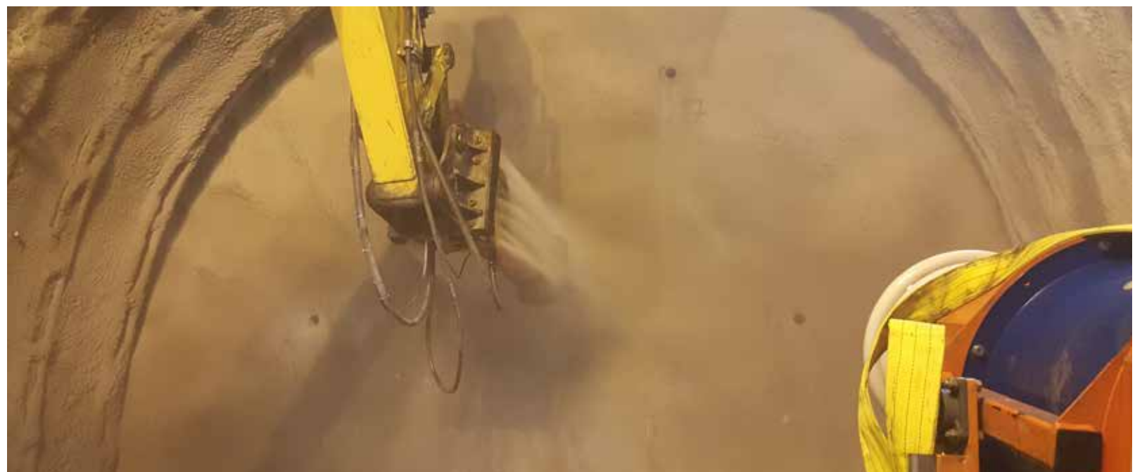
NEBULIZZAZIONE FRONTE DI SCAVO
