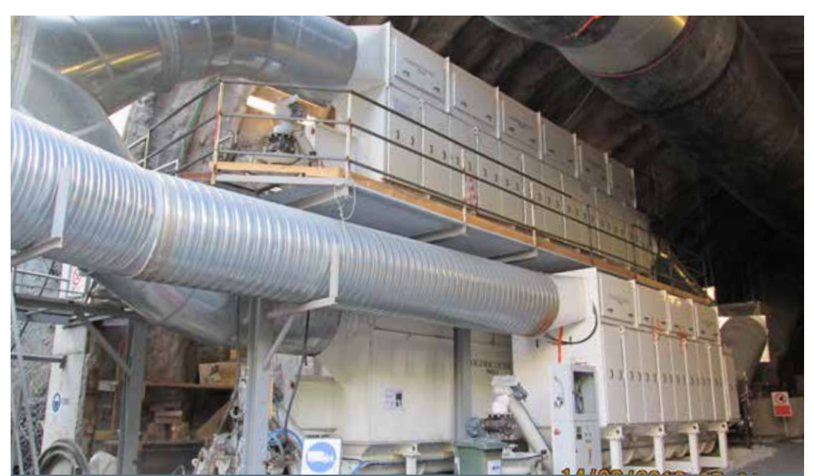
IMPIANTO DI VENTILAZIONE ASPIRANTE
